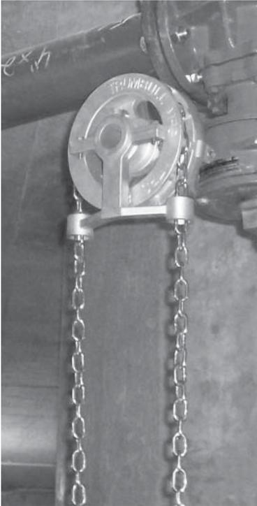
LES VOLANTS À CHAÎNE EN ACIER INOXYDABLE DE TRUMBULL permettent de manœuvrer les valves en hauteur au moyen d'une légère traction sur la chaîne. La conception universelle du volant à chaîne permet de l'attacher à un volant de manœuvre ou directement à la tige de la valve.
