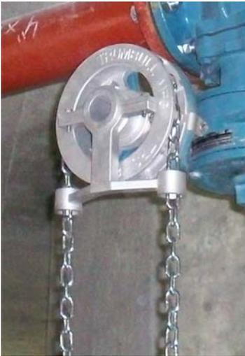
**EDELSTAHL-KETTENRÄDER VON TRUMBULL** ermöglichen die Betätigung von Armaturenhandrädern in unzugänglichen Höhen durch leichten Zug an der Kette. Dank ihrem Universaldesign können die Kettenräder am Handrad montiert oder direkt an der Armaturenspindel verstiftet werden.
